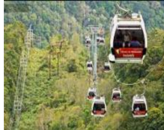
Teleférico para acceso
